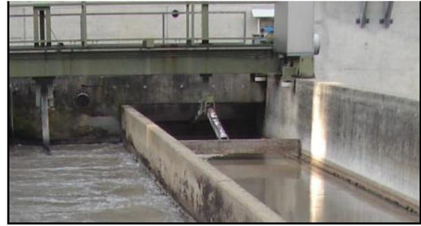
Viennent ensuite les étapes du **déssablage** et **dégraissage**. On ralentit les mouvements de l'eau ; la graisse remonte à la surface et le sable coule au fond du bassin. Ils sont ramassés par des racleurs. On injecte de l'air pour que le sable se dépose plus facilement.
