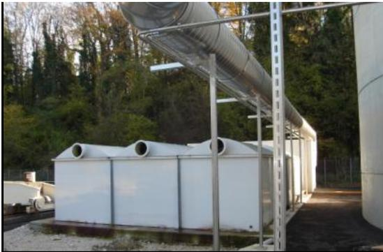
Une partie des mauvaises odeurs est aspirée dans des grands tuyaux d'aluminium puis filtrée.
