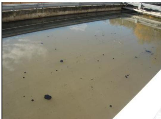
Dans le **décantateur primaire**, on laisse le temps aux boues de se déposer au fond.
